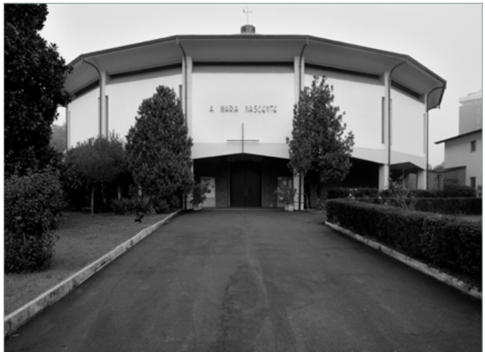
CHIESA DI S. MARIA NASCENTE, VISTA DELL'INGRESSO (FOTO DI TOMMASO GIUNCHI)
