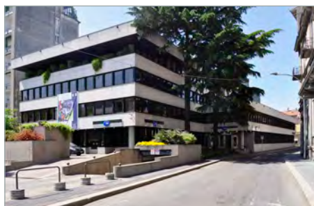
VISTE DELL'EDIFICIO (FOTO DI STEFANO SURIANO)
