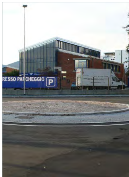
VISTA DALLA STRADA STATALE (FOTO DI ALESSANDRO ISASTIA)
